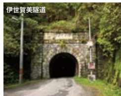
↑長さ308m、高さ3.3m、幅3.15m。このトンネルの竣工によって運送馬車の往来が可能になったという。
